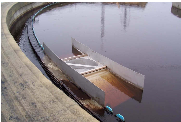
Obr. 6. Klariflokulátor po rekonstrukci
