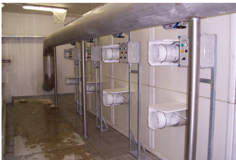
Obr. 5. Pohled na nové horizontální aerační reaktory
